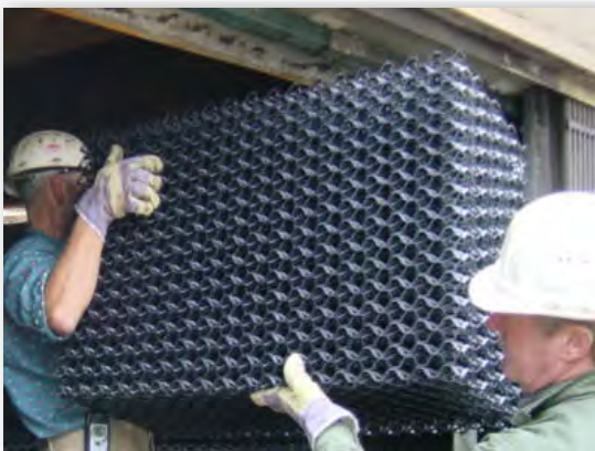
Kühleinbauten aus PVC oder PP-Waben, PP-Gitter, PP-Roste oder Holzlatten
