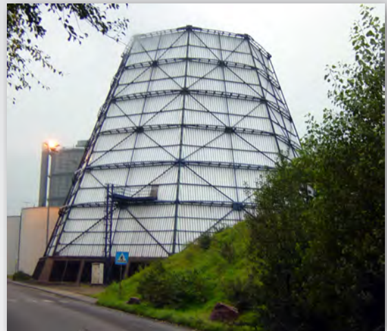
Abnehmen einer korrodierten Kühlturmkrone und Erneuerung der Wandverkleidung
