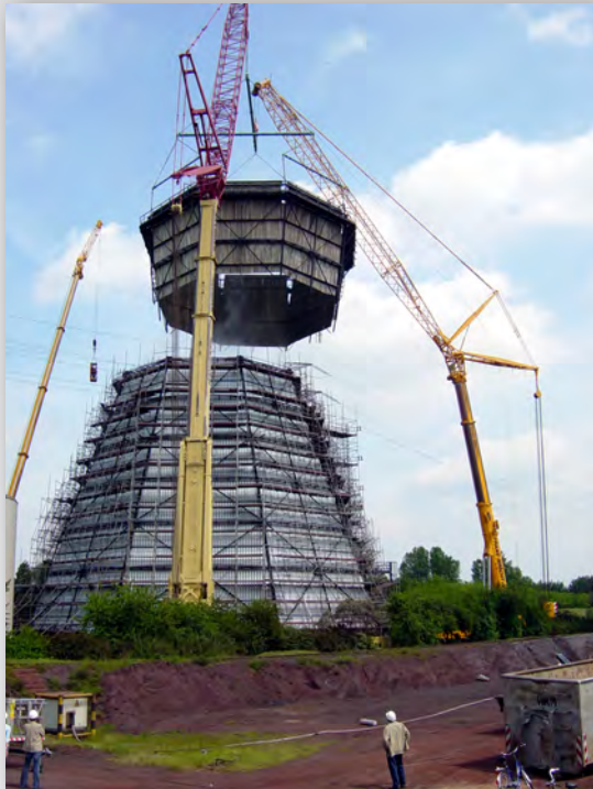
Komplette Sanierung eines Naturzugkühlturms mit Holzverkleidung und Holzlatteneinbau
