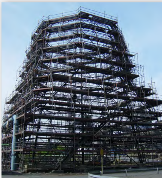
Komplette Sanierung eines Naturzugkühlturms mit Holzverkleidung und Holzlatteneinbau
