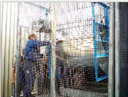
Einbau eines neuen Radialventilators
