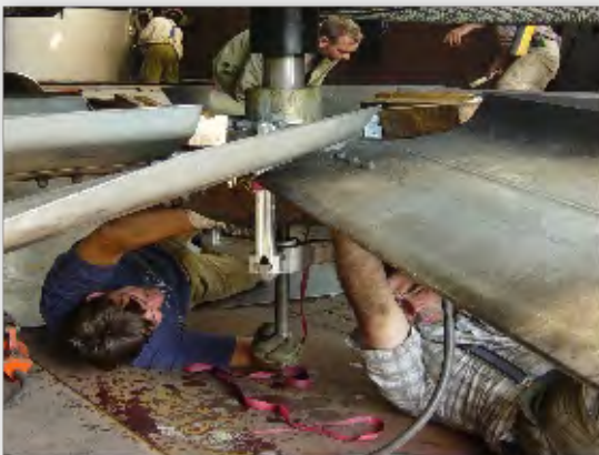
Einbau eines neuen Radialventilators
