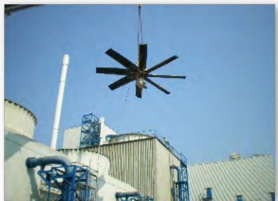
Einbau eines neuen Axialventilators
