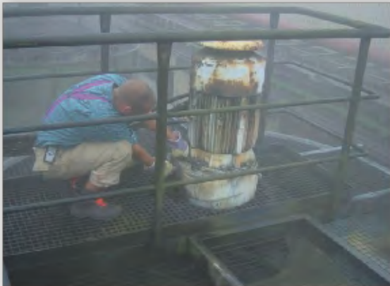
Wechsel eine feststehenden Ventilatorlaufrades
